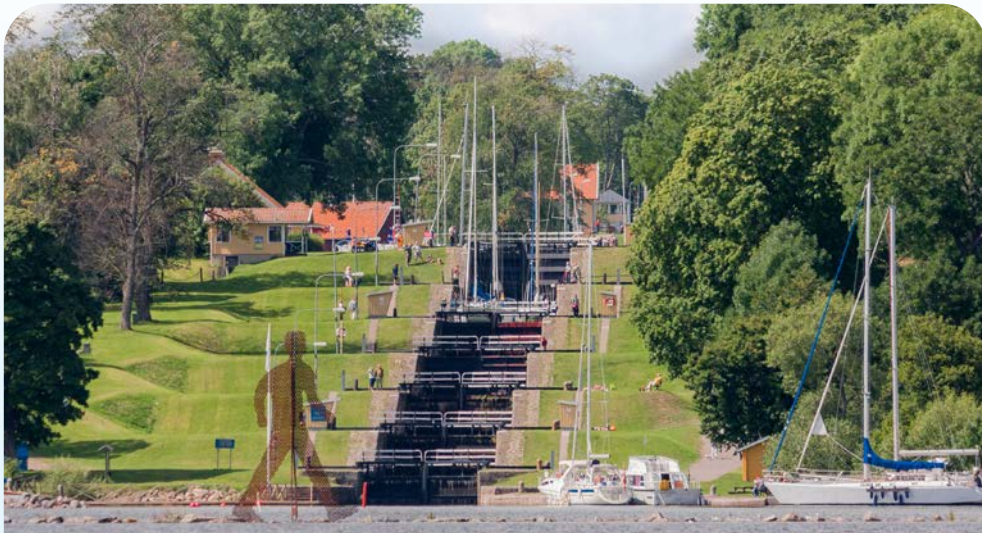
Die Schleusen des Götakanals
