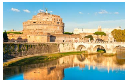
Blick auf die Engelsburg
